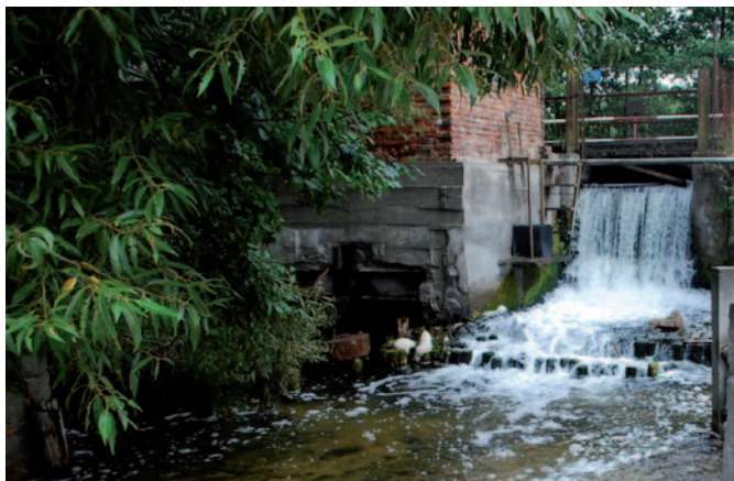
◀ Fot. 5 „Jaz piętrzący”
